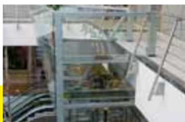
Крепление ограждений и металлоконструкций лифтового подъемника к плитам перекрытия
