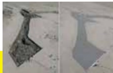
Самовыравнивание смеси при заливке пустот, широких трещин и труднодоступных зон
