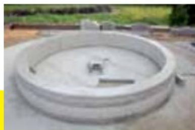
Соединение конструктивных элементов и монтаж облицовки фонтана, выполненных из природного камня
