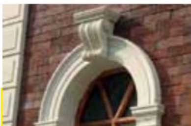
Монтаж наружных элементов архитектурного декора (CERAM — сертификат морозоустойчивости)
