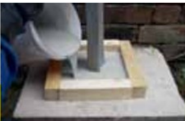
Высокоточная подливка оснований фундаментов
