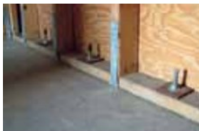
Установка анкерных и фундаментных болтов
