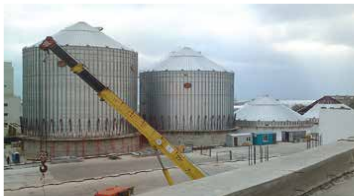
Монтаж металлических силосов общей вместимостью 51 432 тонн (Зерновой Терминальный комплекс «Тамань», Краснодарский край, 2010 г.)
