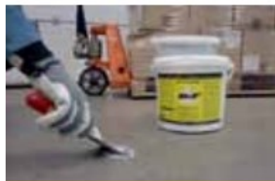
Оперативный ремонт дефектов промышленных наливных полов
